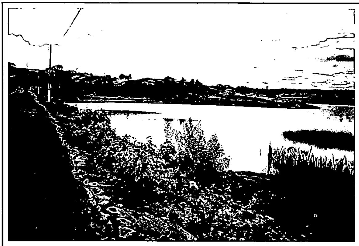
FOTOS 07 e 08/30 - VISTA DO PEQUENO AÇUDE EXISTENTE EM CATARINA QUE INTEGRA O SISTEMA COMPLEMENTAR DE ABASTECIMENTO D'ÁGUA, POIS EM ANOS SECOS, TRANSFERE VAZÃO PARA A FONTE HÍDRICA ATUAL DO SISTEMA.
