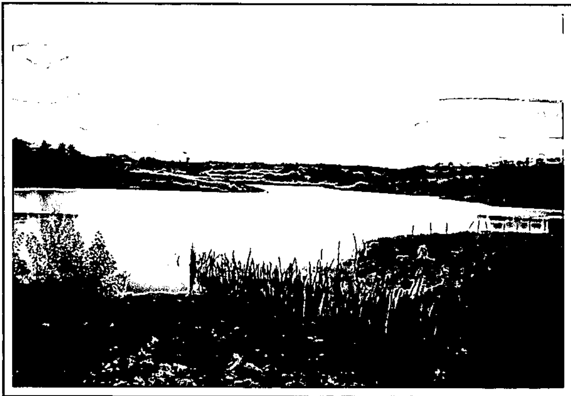
FOTOS 07 e 08/30 - VISTA DO PEQUENO AÇUDE EXISTENTE EM CATARINA QUE INTEGRA O SISTEMA COMPLEMENTAR DE ABASTECIMENTO D'ÁGUA, POIS EM ANOS SECOS, TRANSFERE VAZÃO PARA A FONTE HÍDRICA ATUAL DO SISTEMA.
