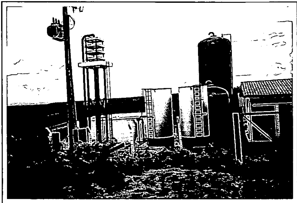
FOTO 03/30 - VISTA GERAL DO SISTEMA DE ABASTECIMENTO D'ÁGUA DE CATARINA.
